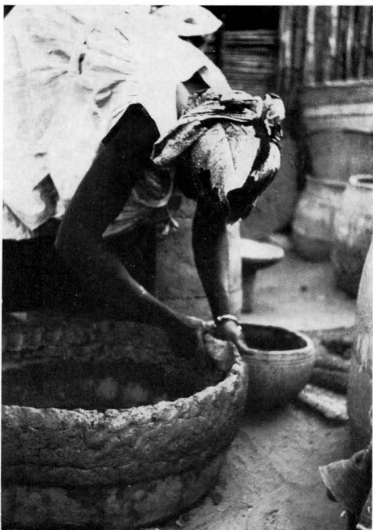
4. Mourdiah. 29.I.65. Potière Kakoro Diara. Début du montage des parois verticales d'un silo à mil. Mise en place d'un colombin d'argile.
